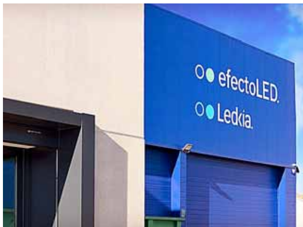
Instalaciones de EfectoLed en Oliva (Valencia)
